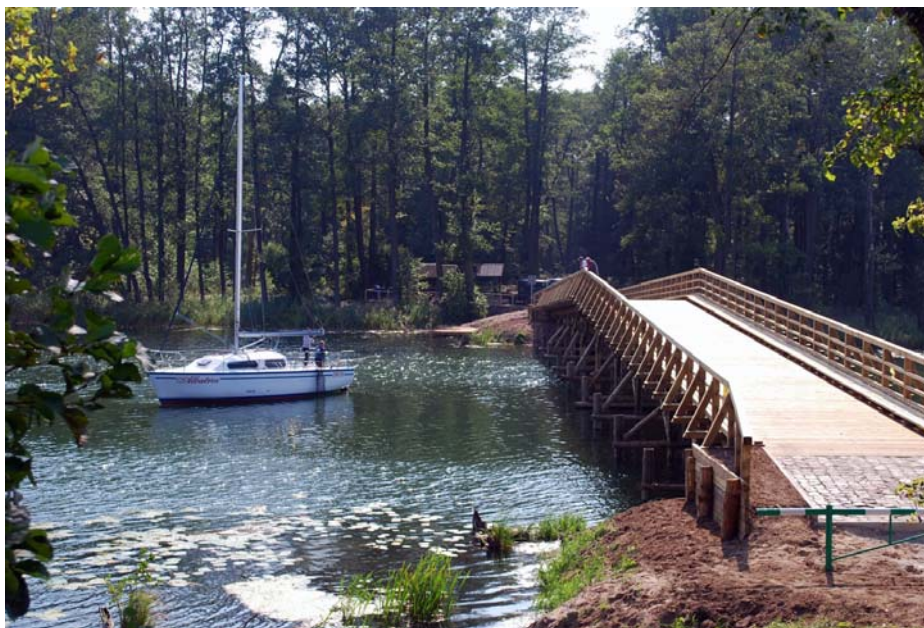
Ryc. 5-3. Most na przesmyku jeziora Osiek
