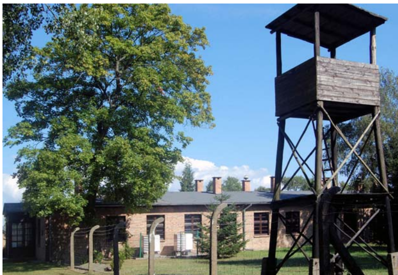
Ryc. 4.5-1. Budynek Muzeum Woldenberczyków. Na pierwszym planie rekonstrukcja wieży wartowniczej i częściowa rekonstrukcja ogrodzenia
